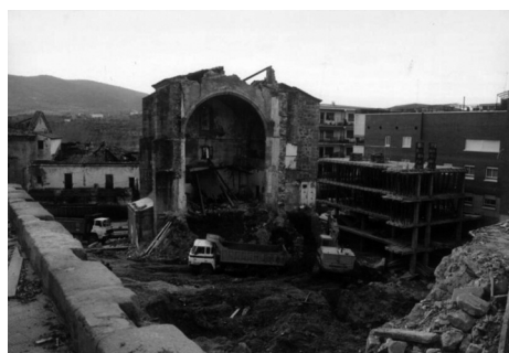
Fig. 50 Hospital de la Merced durante el proceso de demolición y movimiento de tierras. Foto Hoy.
