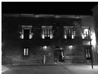
Fig. 31 Pascual. Fachada principal después de la intervención. Foto Matesanz.
