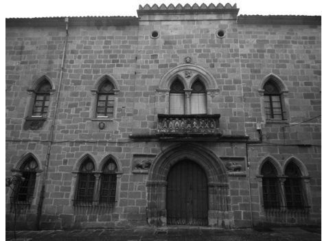
Fig. 45 Mirón. Estado actual de la fachada totalmente transformada. Foto Matesanz.
