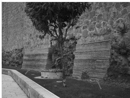
Fig. 11 Feduchi y Temprano. Ronda de Higerillas. Refuerzos de hormigón y recrecidos con mampostería. Foto Matesanz.
