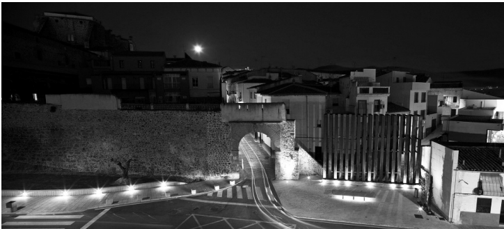
Fig. 15 Rubiolo. Muralla junto a la puerta de Coria. Después de la actuación. Foto Subliminal.
