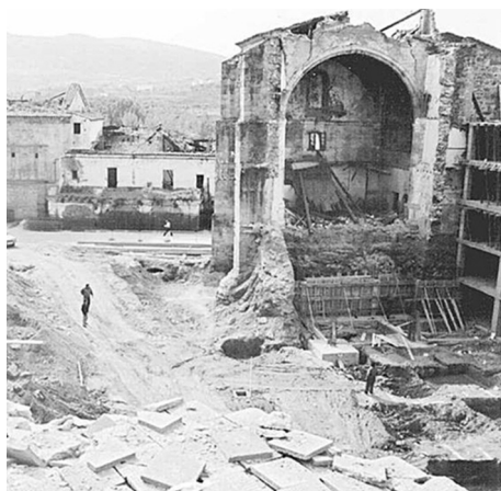
Fig. 51 Hospital de la Merced durante el proceso de demolición y movimiento de tierras. Foto Hoy.
