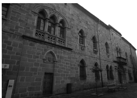
Fig. 44 Mirón. Estado actual con la torre desmontada y la fachada totalmente transformada. Foto Matesanz.
