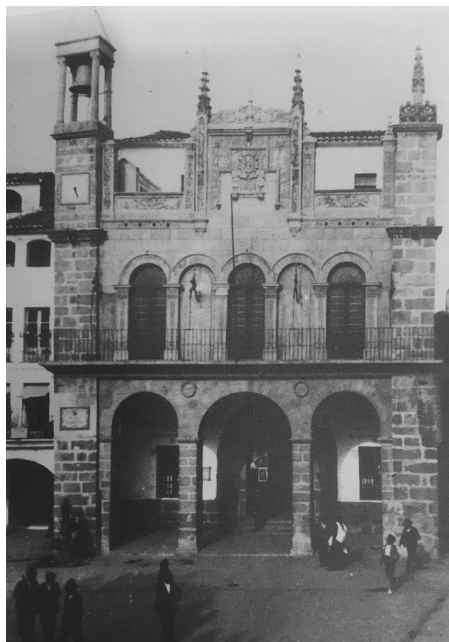
Fig. 41 Fachada Ayuntamiento. Francisco Mirón. Fachada realizada en 1935.
