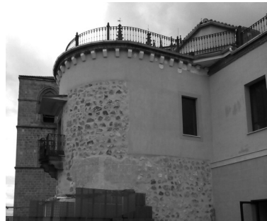
Fig. 35. Diz Plaza. Vista hacia el oeste con el cubo restaurado. Zona de ampliación del s. XX. Foto Esperanza Rubio.
