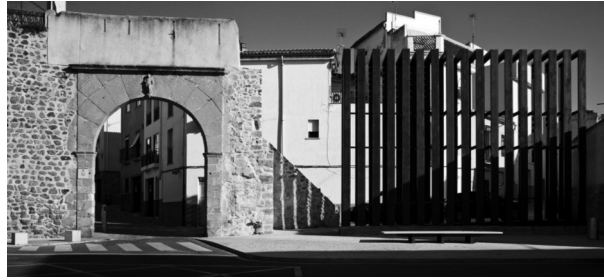
Fig. 14 Rubiolo. Muralla junto a la puerta de Coria. Después de la actuación. Foto Subliminal.
