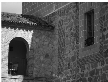
Fig. 22 Martitegui. Realizada la intervención. Nuevo edificio en la esquina NO. Falso histórico. Detalle de la zona de conjunción del nuevo edificio con el antiguo. Foto Matesanz.
