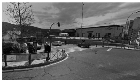
Fig. 54 Hospital de la Merced vista general del estado actual desde la zona de la puerta de Talavera. Foto Matesanz.
