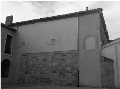
Fig. 34 Diz Plaza. Vista del lateral este en la zona de ampliación del s. XX. Paramento antiguo y la muralla seccionada. Foto Domingo Martín.
