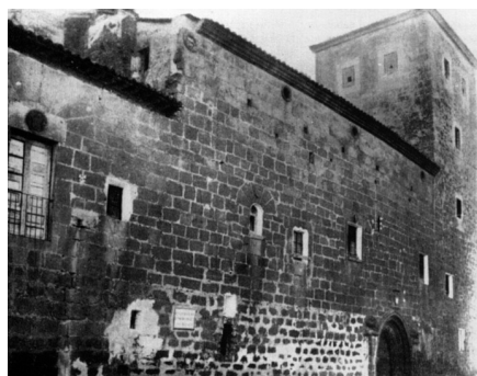
Fig. 43 Fachada del palacio de Monroy antes del desmontaje de la torre oeste.
