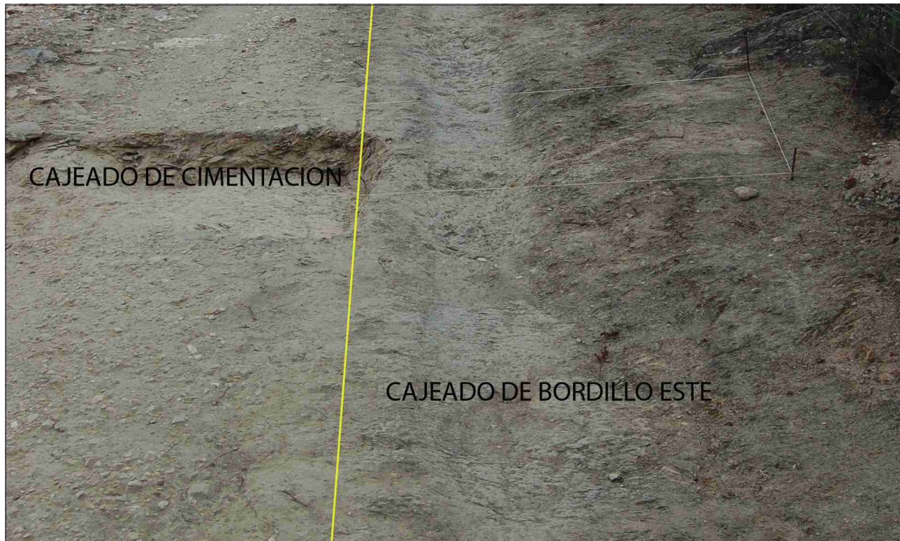
Fig. 13. Detalle de cajeados de cimentación y de bordillo en lateral oriental.
