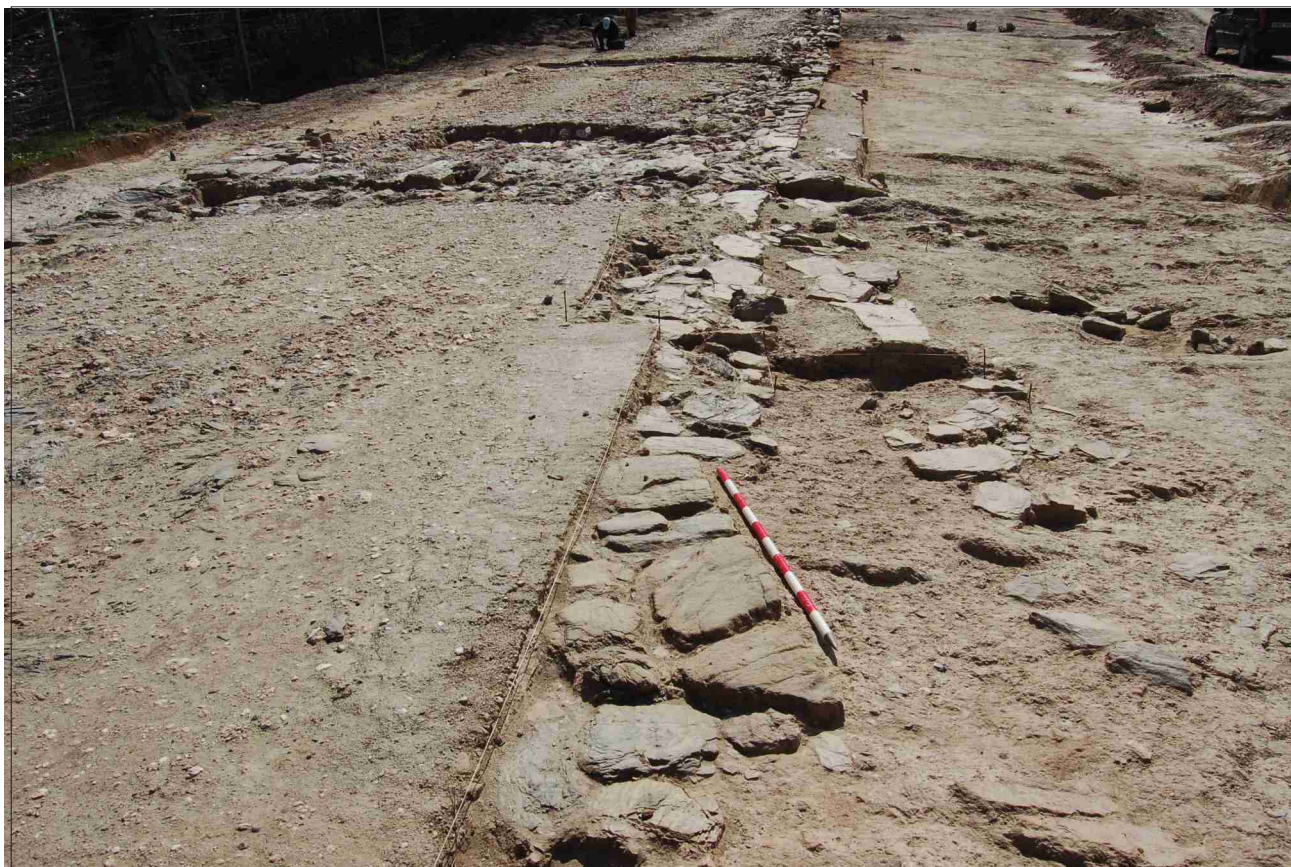
Fig. 16. Restos de bordillo occidental. Mal estado de conservación.
