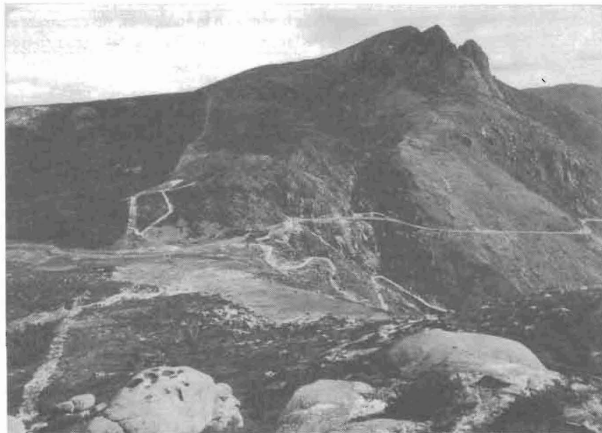
Figura 2. Calzada del Puerto del Pico. Detalle del Puerto y último tramo de la calzada.
