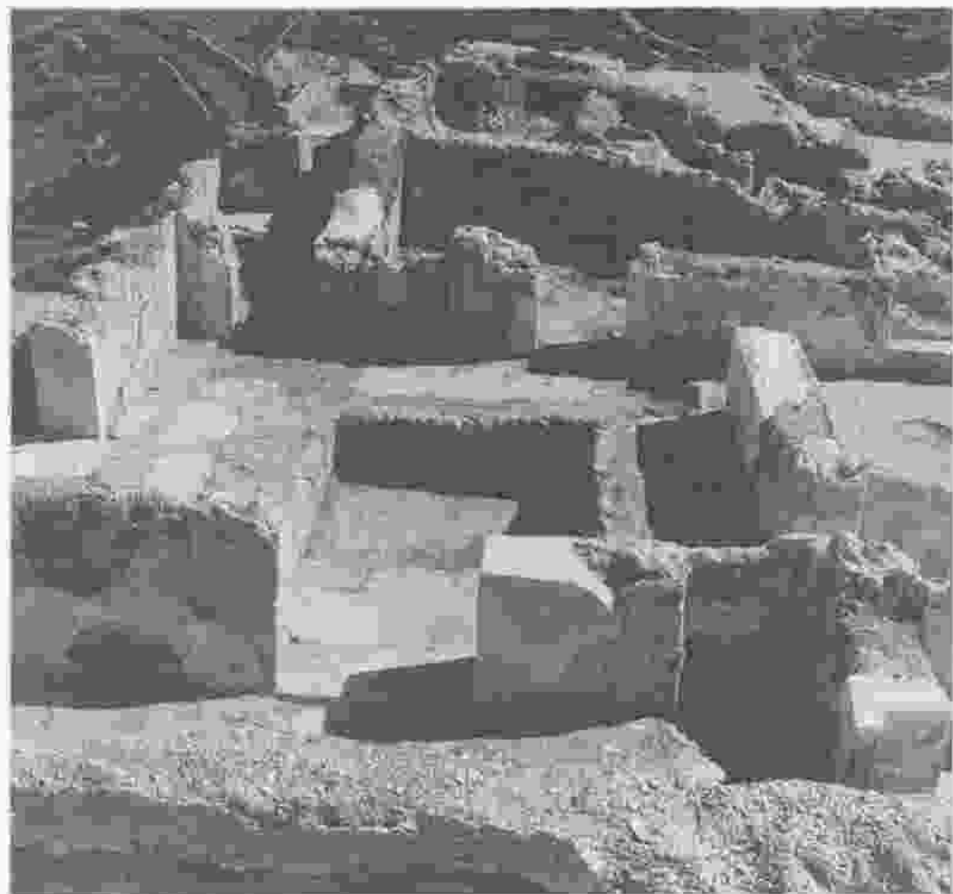
Edificio 17.—CIEZA (Murcia). Ciudad árabe restaurada en 1984 con yeso para configurar las formas de los vanos, pero sin tratar en cuanto a la conservación de muros, estructuras y grafitos de las yeserías originales.
