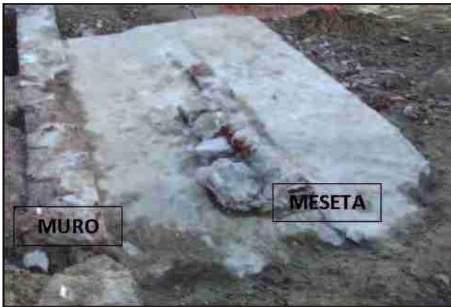
Figura 13. Muro de contención lateral a la terraza de Ayuntamiento y la meseta adosada a éste.
