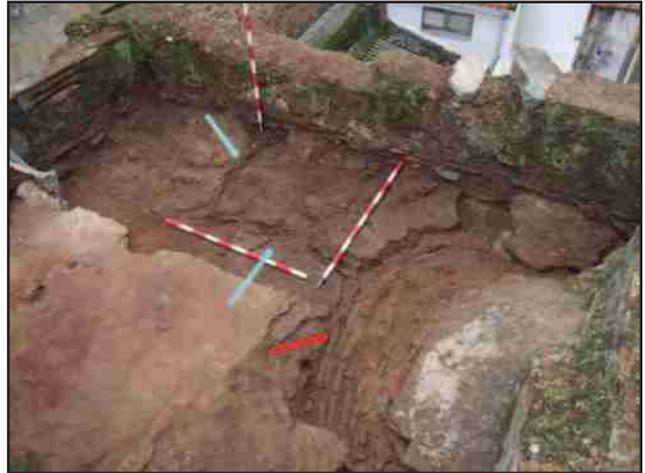
Figura 5. Sección en la que se puede ver la estructura general del tapial, la línea de rotura por la escalera y grietas constructivas.
