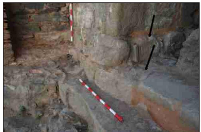
Figura 13. Zona de la cimentación del arco albarrano con dos zarpas.
