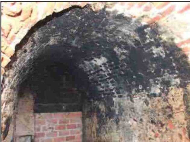
Figura 11. Bóveda quemada por efecto del horno en la parte inferior del arco.
